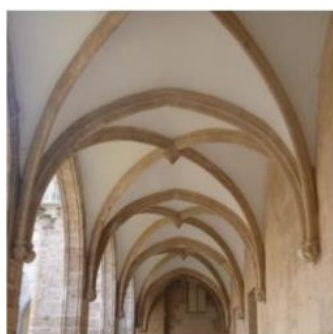
Bóveda de crucería cisterciense. Abadía de Fontanay. SXII. Aunque la arquitectura cisterciense es pionera en el uso de bóvedas de crucería, sus edificios siguen una lógica constructiva típicamente románica
